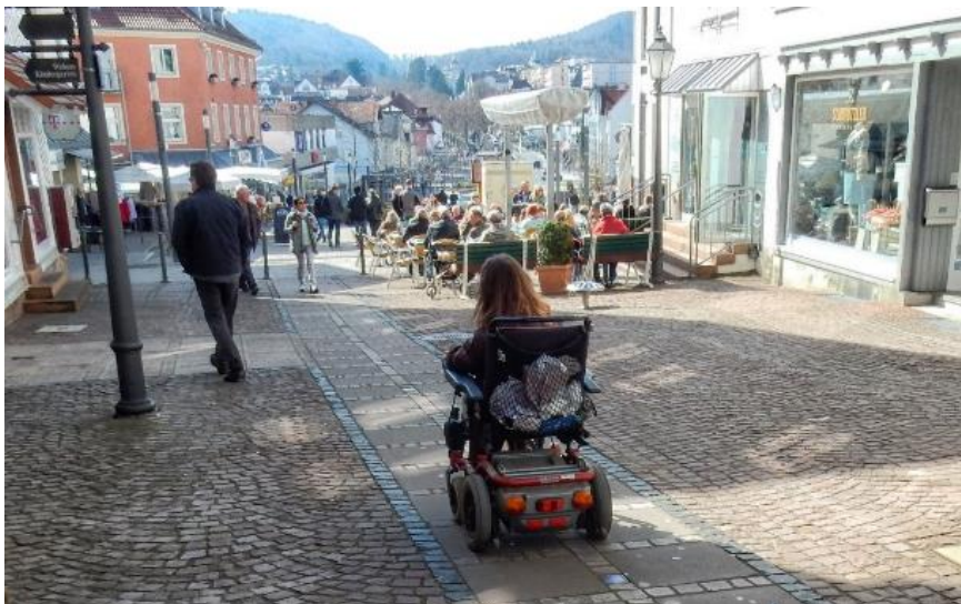
Abbildung 91: Beispiel einer glatten Gehbahn in historischem Kopfsteinpflaster
