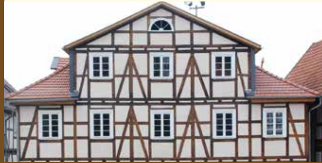
Sanierte Fassade, aufgewertet durch die Fenster
