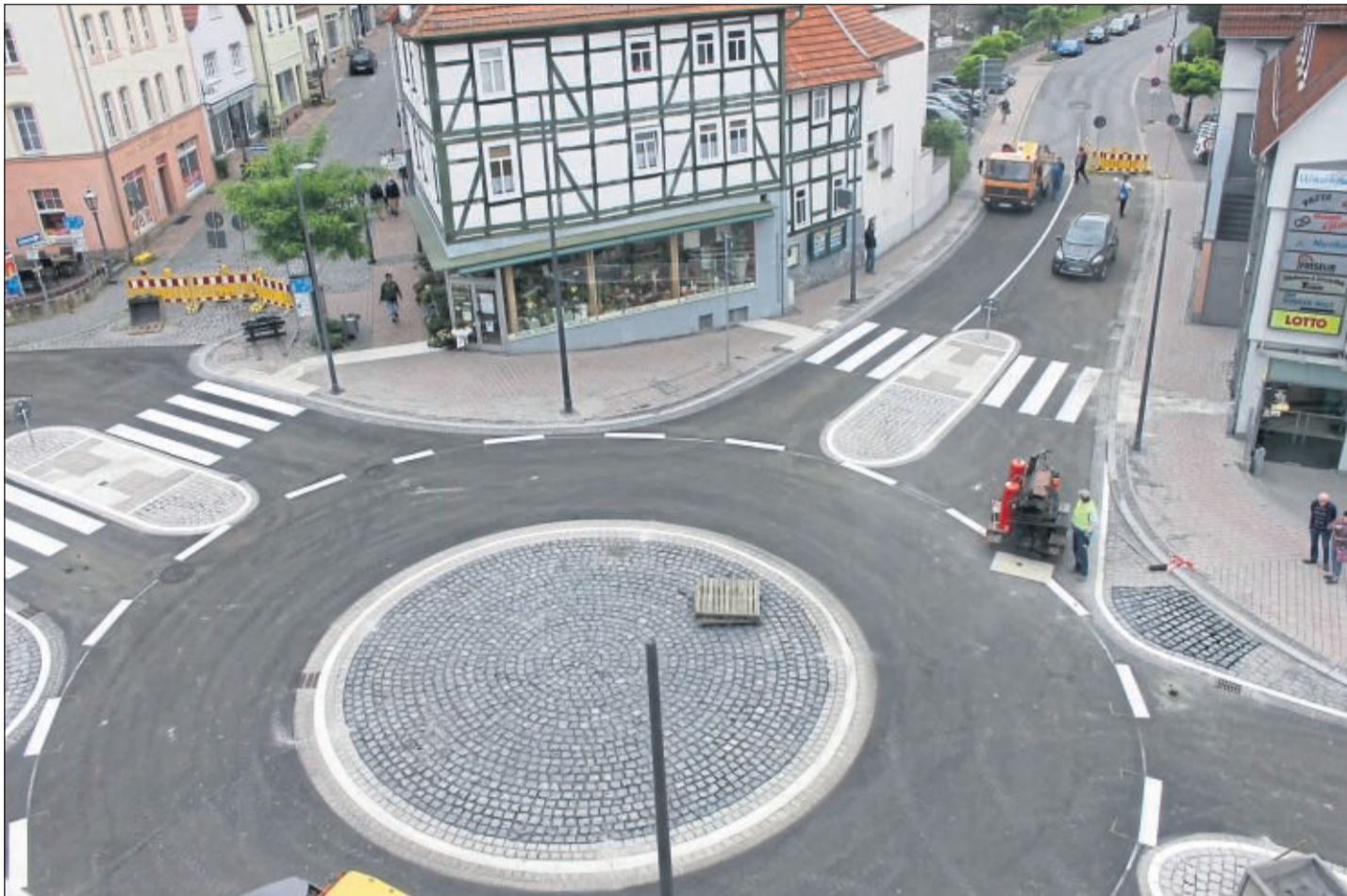
Ab heute dreht sich hier der Verkehr im Kreis: Der Kreisel an der Homberger Drehscheibe ist fertig und wird heute feierlich eröffnet. Das Bild entstand am Freitagmorgen bei den letzten Arbeiten. Foto: Thierry
