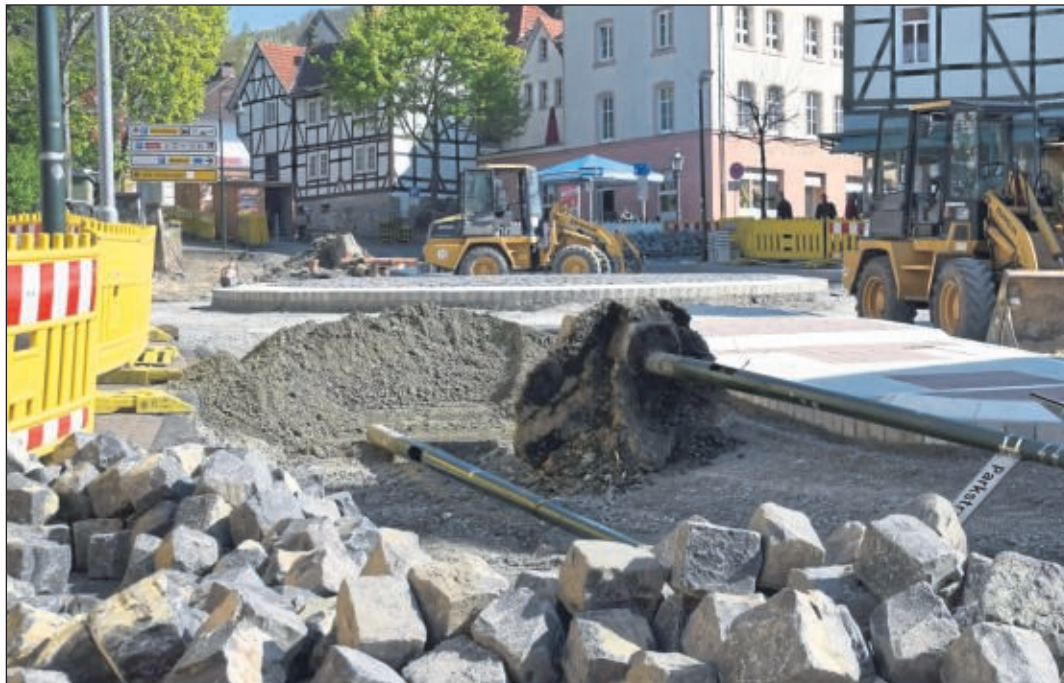
Es geht voran: Minikreisel und Verkehrsinseln an der Drehscheibe sind so gut wie fertiggestellt. Im nächsten Schritt sollen die Gehwege gepflastert werden, auch der Asphalt fehlt noch. Foto: C. Müller
