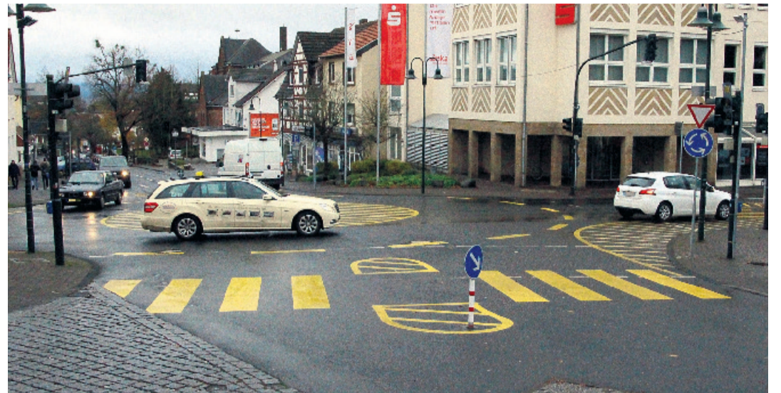
Nach gut eineinhalb Jahren Provisorium beginnen am 26. März die Bauarbeiten für den neuen Mini-Kreisel in Homberg. Foto: von Lengerken
