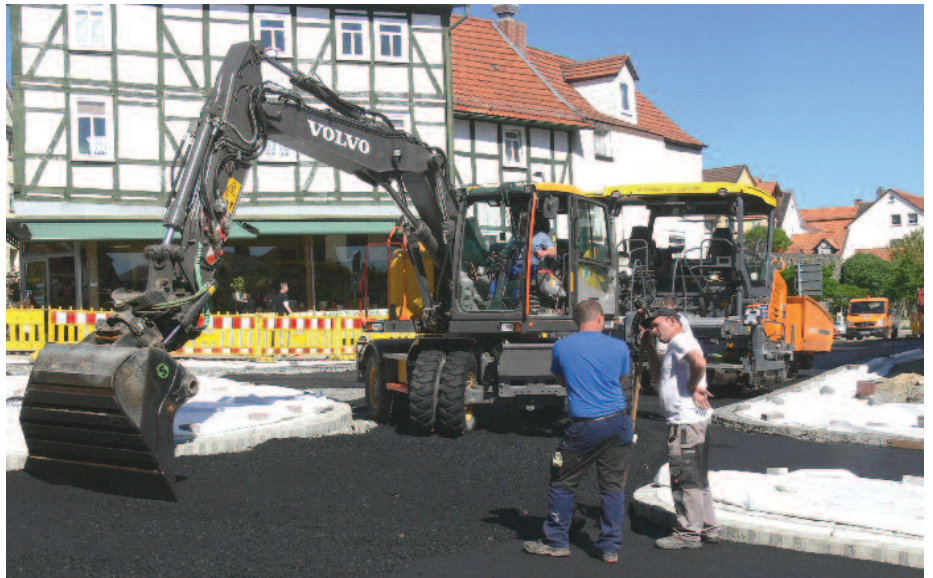
Zuerst ist die bituminöse Tragschicht eingebaut worden. Danach folgte die Binderschicht und zuletzt die Deckschicht. Fotos: Uwe Dittmer
