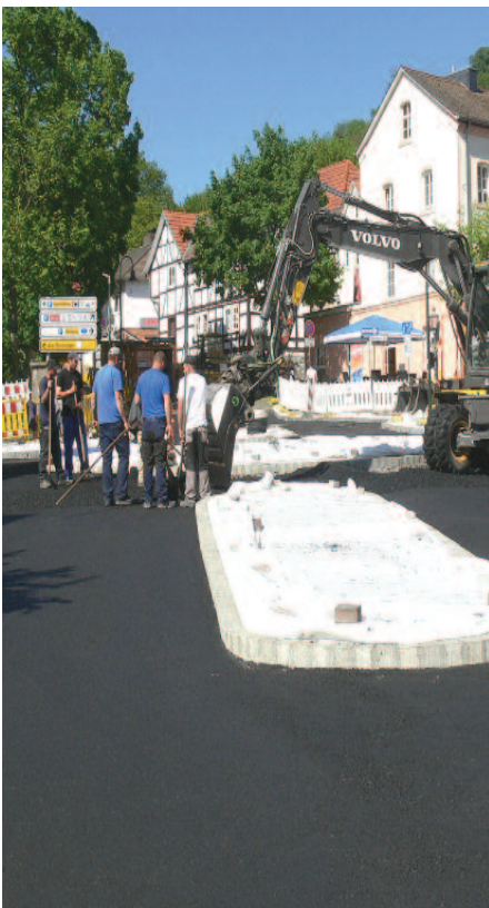
Die Straße ist schon zu sehen. Alles wurde ge-teert.
